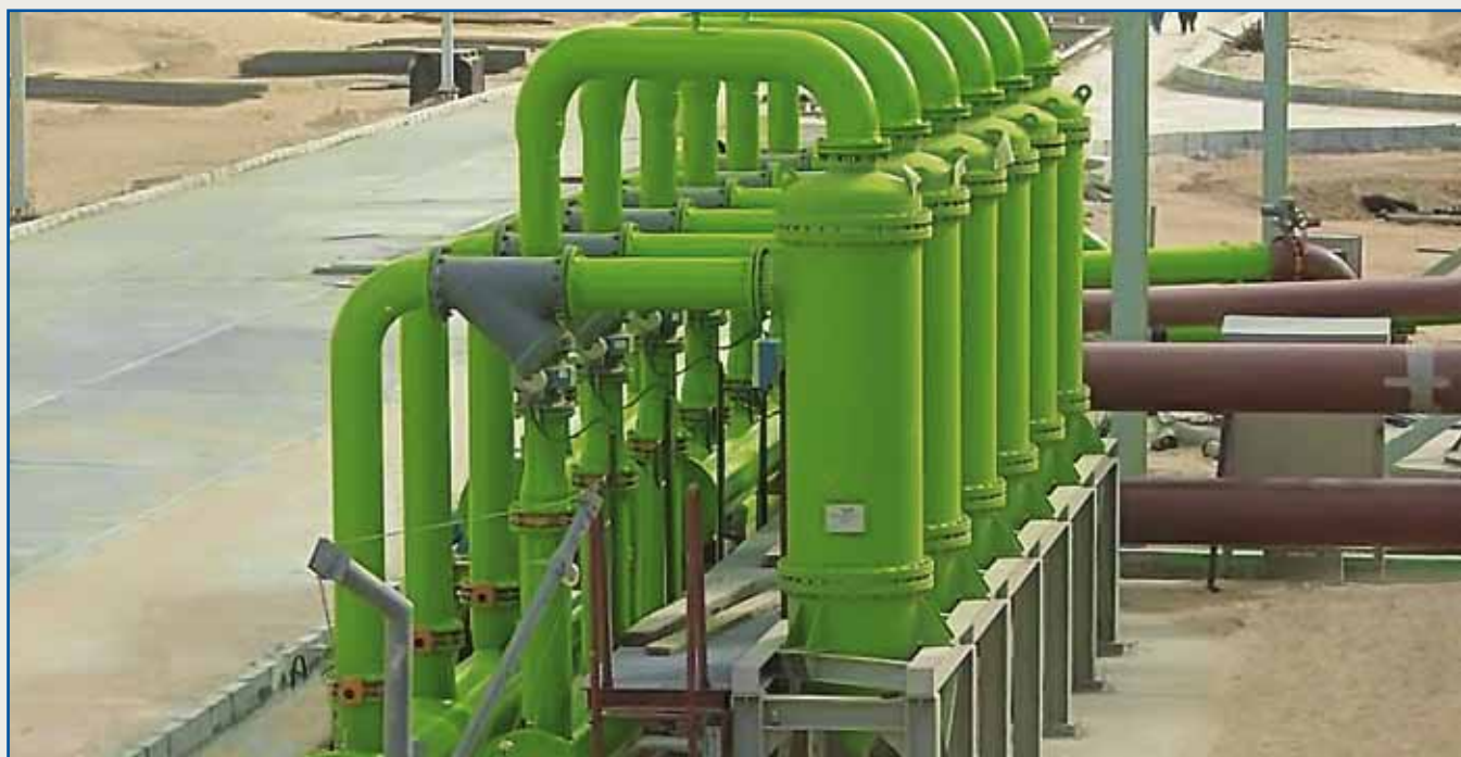
Рис. 7 Фильтрация sprысковой воды на прокатном стане.
