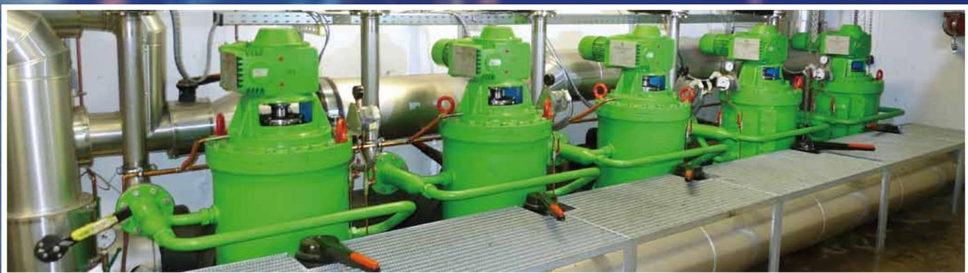
Abb. 18: MUSCHEL STOP-Anlage in der Flussfiltration
