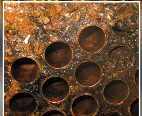
Abb. 7: Muschelbefall im Rohrbündelwärmetauscher
