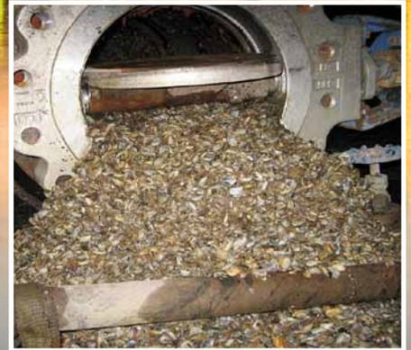
Abb. 6: Muschelbefall an Filterelementen und Rohrleitungen
